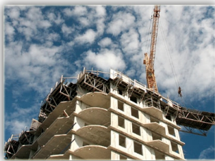
Строительство, ремонт, отделка, квартир, офисов
